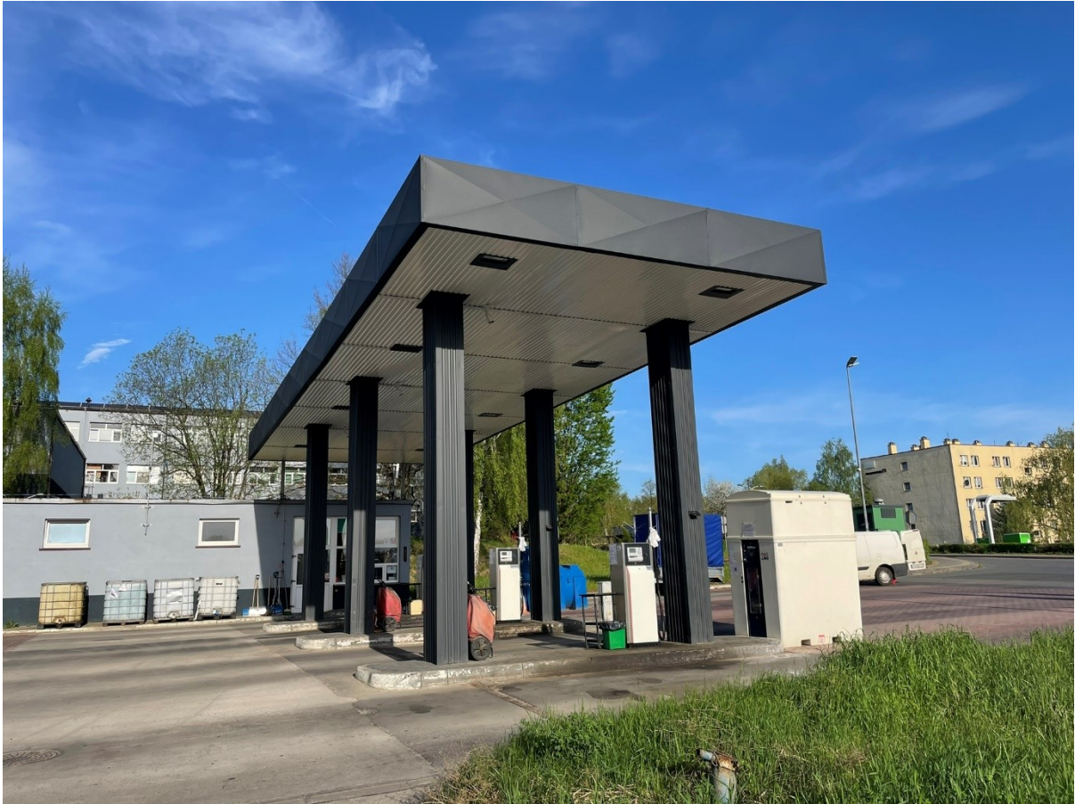
Zmodernizowana stacja paliw PKM Sosnowiec sp. z o.o. w oddziale w Sosnowcu
