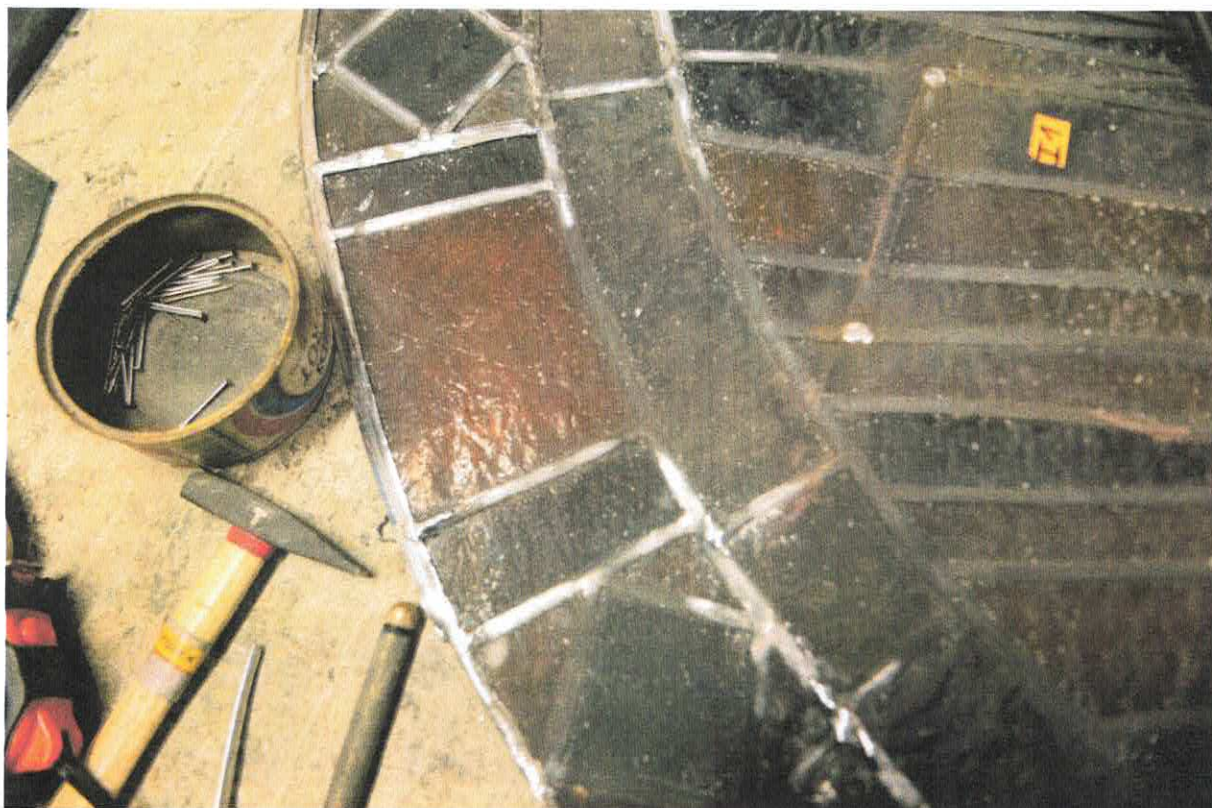
Zdjęcie nr 4. Katedra w Sosnowcu. Witraż Alfa i Omega w trakcie konserwacji. Wymiana uszkodzonych profili ołowianych.
