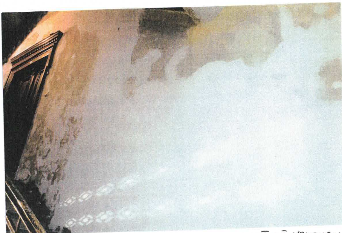
FOT. 1. ŚCIANA PRZY SCHODACH POMIĘDZY I, II KONDYGNACJĄ
