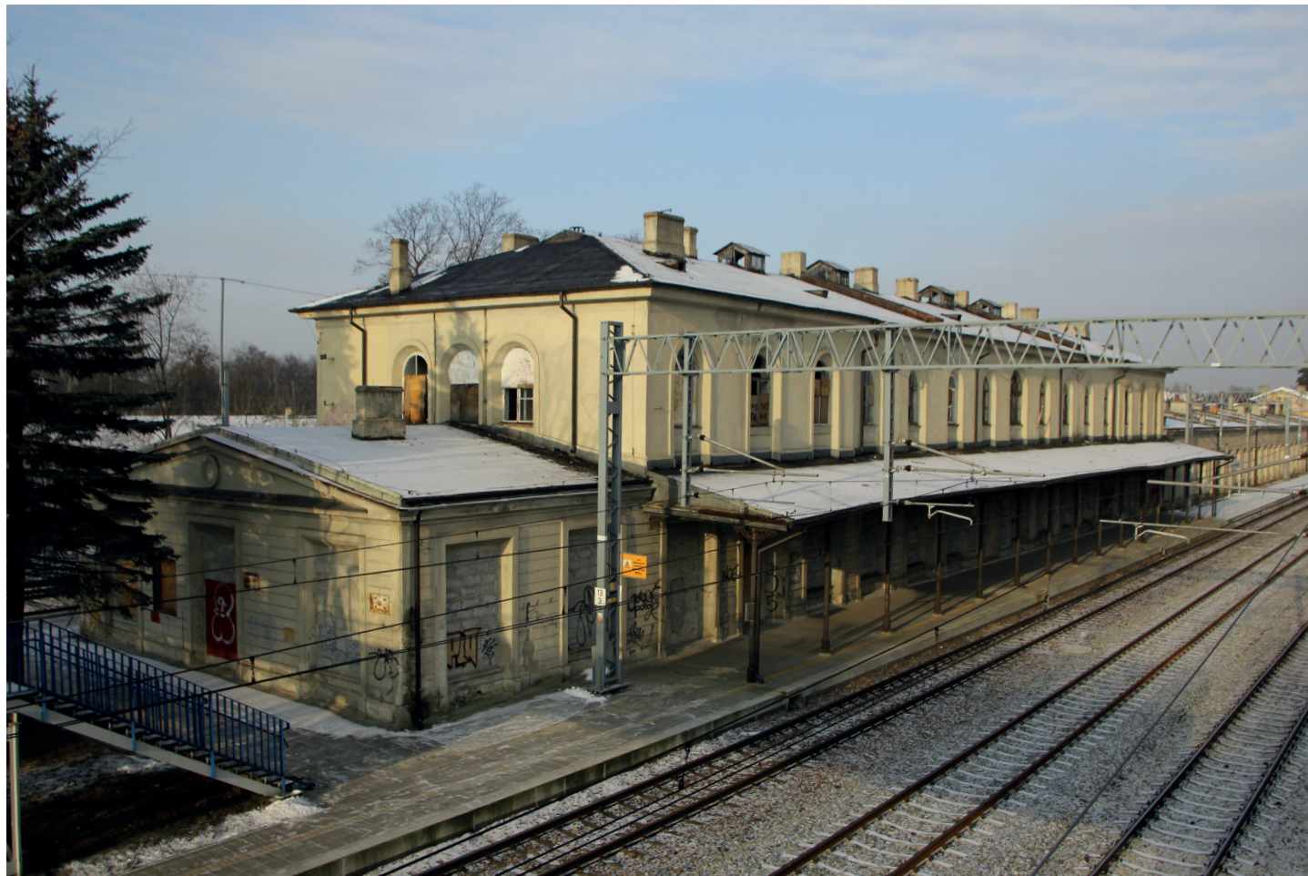
Budynek dworca Kolejowego Sosnowiec-Maczki. Powstał w latach 1839-1848. Stan zabytku w trakcie prac konserwatorskich, które zostały przerwane przez inwestora.
