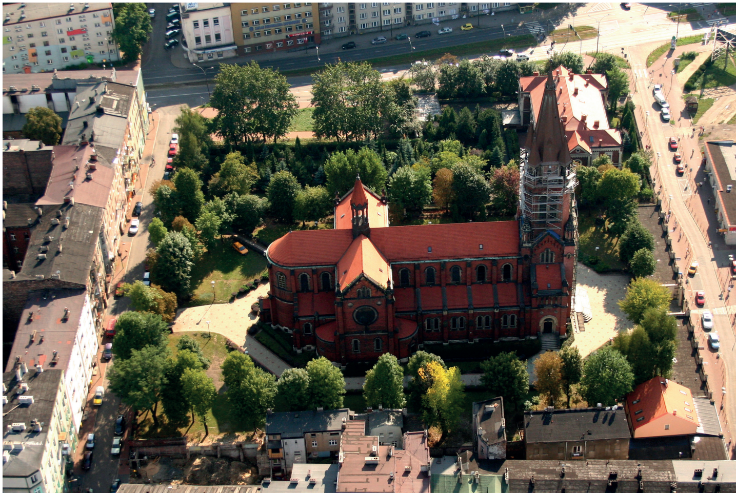
Kościół pw. Wniebowzięcia NMP wraz z zespołem zabudowań katedralnych, ul. Kościelna.
