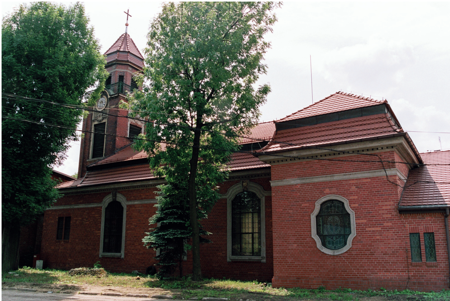
Kościół ewangelicko-augsburski, ul. Żeromskiego 1. Budynek ukończony ok. I połowy lat 90-tych XIX w. Styl eklektyczny z przewagą form neobarokowych. Stan zabytku dobry.
