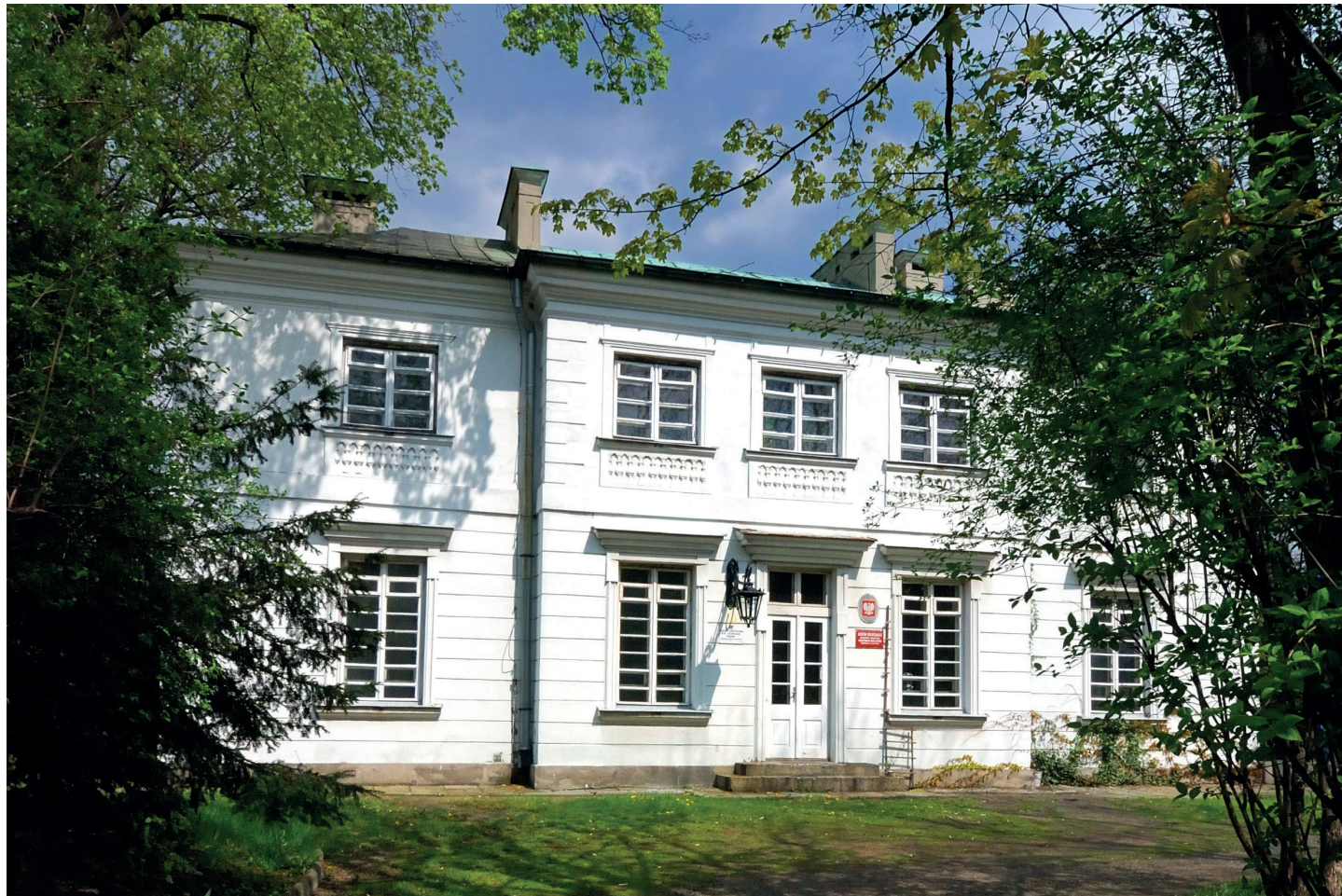
Pałacyk klasycystyczny, ul. Szpitalna. Powstał pod koniec XIX w. Fundatorami i właścicielami była rodzina Mieroszewskich. Stan zabytku dostateczny.
