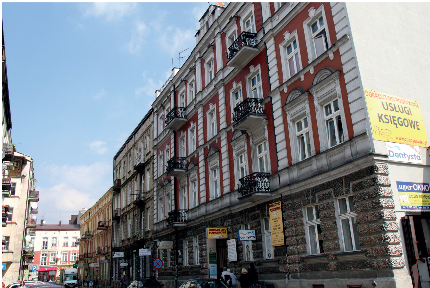
Kamienica mieszkalna, ul. Dekerta 6. Powstała na przełomie XIX/XX w. w stylu historyzmu. Stan zabytku dobry.
