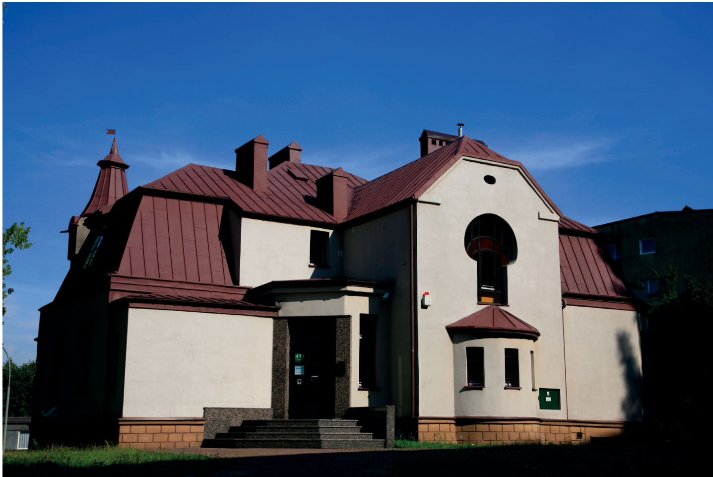
Budynek, ul. Będzińska 41/I. Budynek zbudowany w 1923. Przykład budownictwa mieszkaniowego typu willowego. Stan bardzo dobry.
