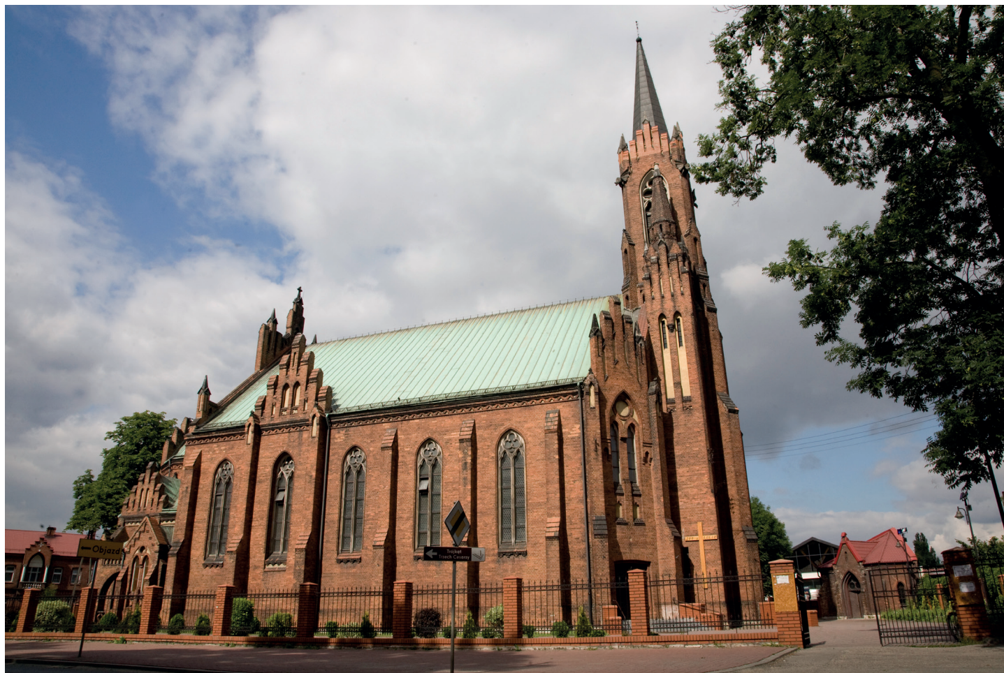
Kościół pw. św. Jana Chrzciciela, ul. Orłąt Lwowskich. Kościół powstał wg projektu Józefa Pomian Pomianowskiego, zbudowany został w latach 1894-1899 w stylu neogotyckim. Stan zabytku ogólnie dobry.
