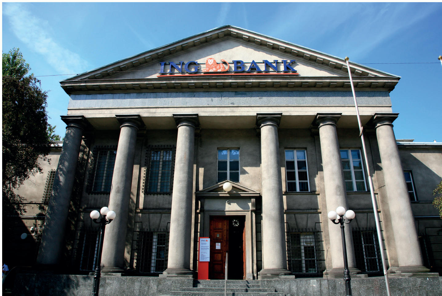
Zespół zabudowań dawnego Banku Polskiego (obecnie ING Bank Śląski), ul. Małachowskiego 7. Obiekt zbudowany w 1924 r. w stylu neoklasycyzmu. Stan obiektu bardzo dobry.
