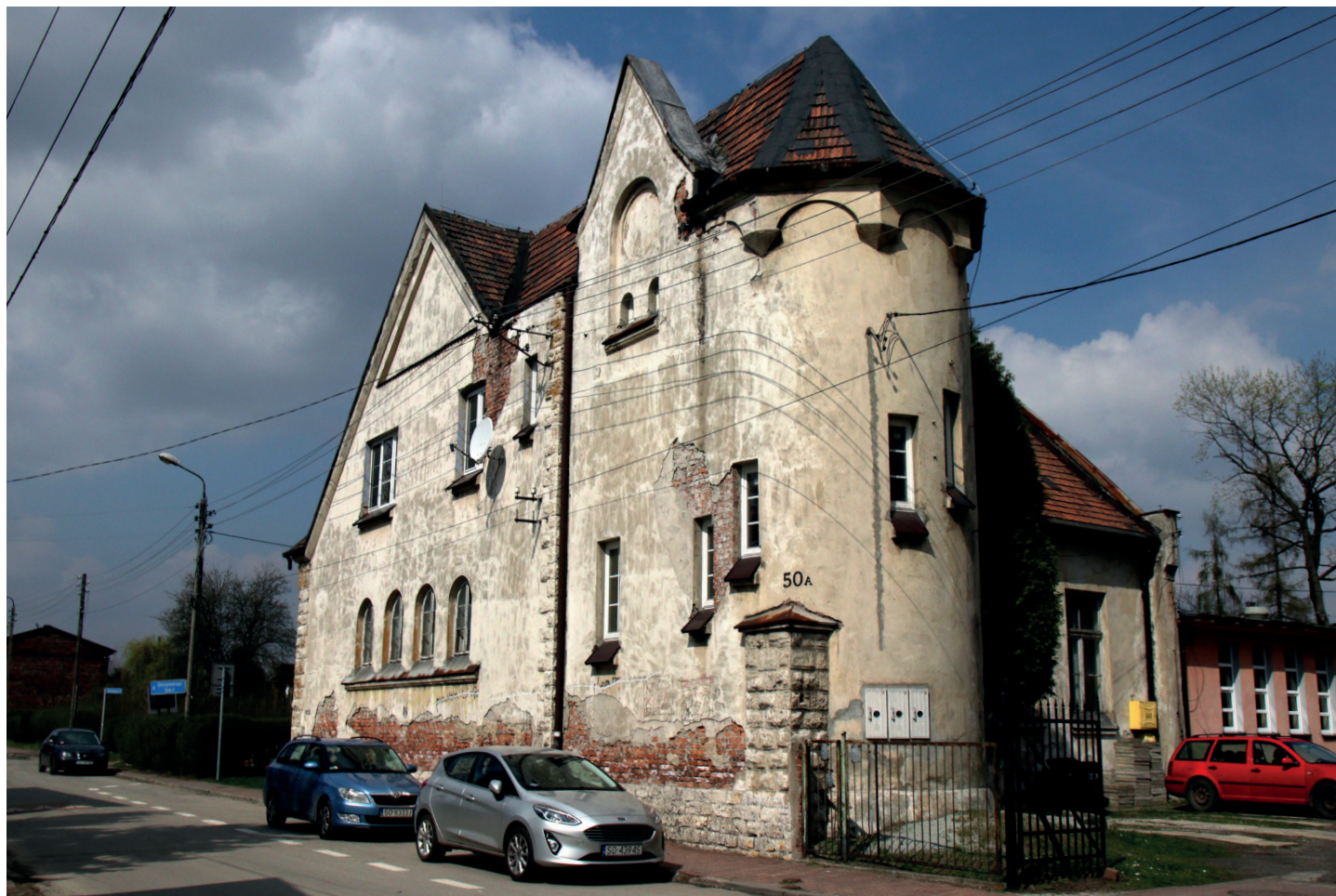
Zespół dwóch budynków szkolnych, ul. Starzyńskiego 50 i 50 a.
