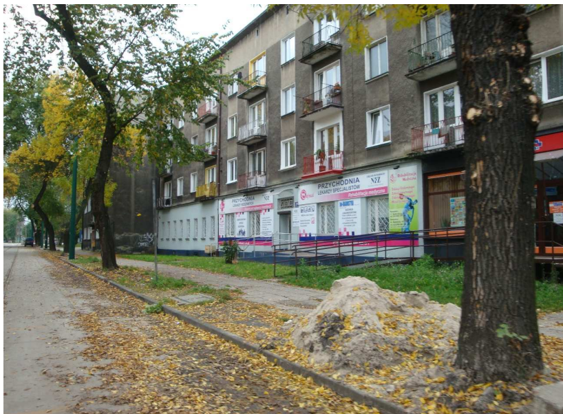
Fot. 11 Zabudowa przy ul. Sobieskiego na terenie 38MW2 - widok od strony skrzyżowania ulic Sobieskiego i Kierocińskiej.
