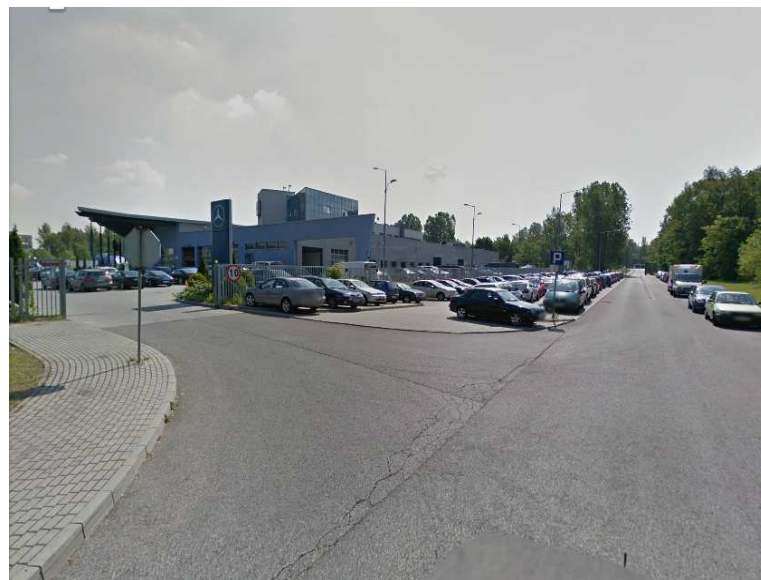
Fot. 50 Salon Mercedes Benz i parking przy ul. Daimlera w południowo-zachodniej części terenu 2U- ekspozycja od strony S86 w kier. wschodnim.
