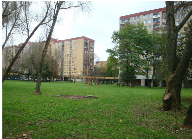
Fot. 32 Centralna część terenu 10MW1 z zabudową wielorodzinną.
