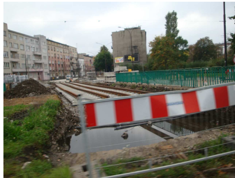
Fot. 2 Widok terenów zabudowy mieszkaniowej (30MW3 i 29MW2) wzdłuż ul. Sobieskiego i terenu 45U ze skrzyżowania z ul. Piłsudskiego.
