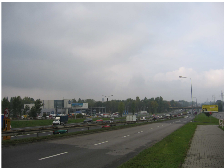
Fot. 51 Zabudowa salonu Mercedes Benz w południowej części terenu 2U przy zachodniej granicy obszaru mpzp -widok z trasy S86 w kier. Katowic.
